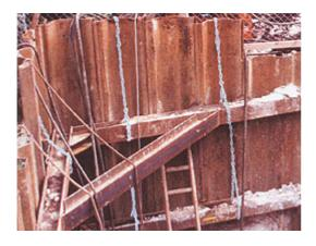
En la construcción de canales y en la utilización de paredes de tablestaca, son las primeras opciones las cadenas de amarre encofrado y cadenas de canal de Wälder, en cuento a un apoyo más seguro se refiere. Si bien no se pueden usar cadenas de amarre para elevar cargas, las con fuerzas de ruptura hasta 40 KN dan un aporte importante para la seguridad en obras de caminos, canales y puertos.
